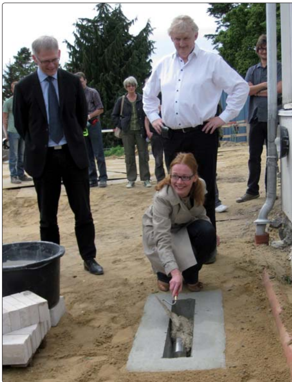
Rådmand Laura Hay dækker grundstenen med den første skovlfuld cement, mens dekan Brian Bech Nielsen (tv.) og direktør Bent Lorenzen (th.) ser på. Foto: Hanne Teghus.
