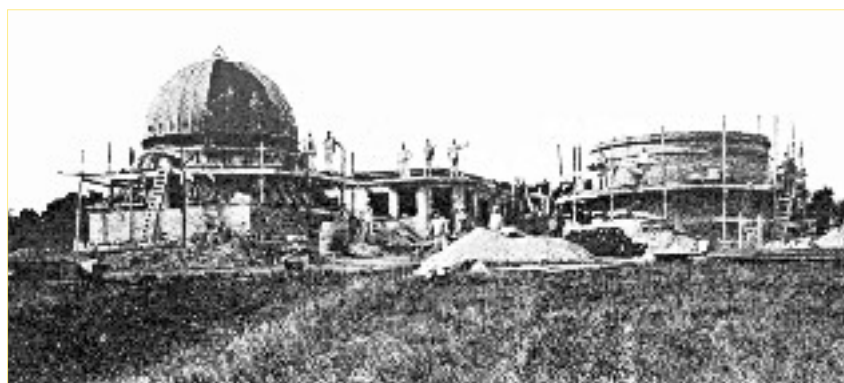
Ole Rømer-observatoriet under opbygning. Friedrich Krüger, observatoriets første leder, "medbragte" selv en kuppel fra sit observatorium i Altenburg. Kuplen er her ved at blive opstillet på sin nye plads. (Fotografi i observatoriets arkiv.)
